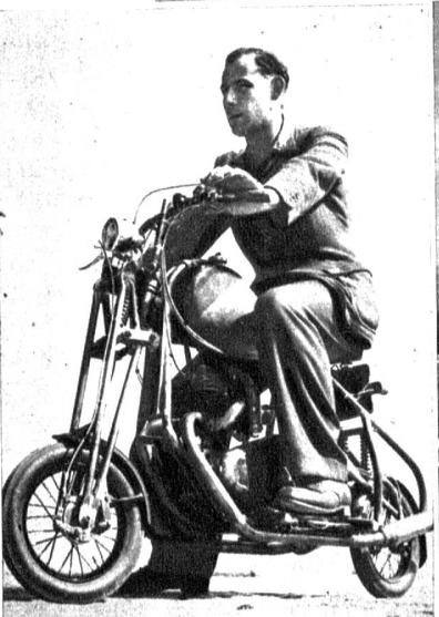
Der junge Postangestellte Maurice Rochat aus Lausanne hat in seiner Freizeit ein Klein-Motorvelo entwickelt, das mit einem 175-ccm-Zweitaktmotor und drei Uebersetzungen ausgerüstet, alle Aussichten hat, zum Verkehrsmittel des kleinen Mannes zu werden. Das Fahrzeug erreicht auf der Landstrasse eine Geschwindigkeit von 50 Stunden-kilometer. (ATP)
