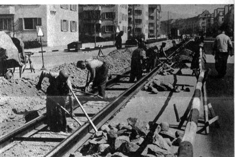
Zwischen den neuangelegten Schienen werden die Löcher für Betonquerschwellen gegraben
