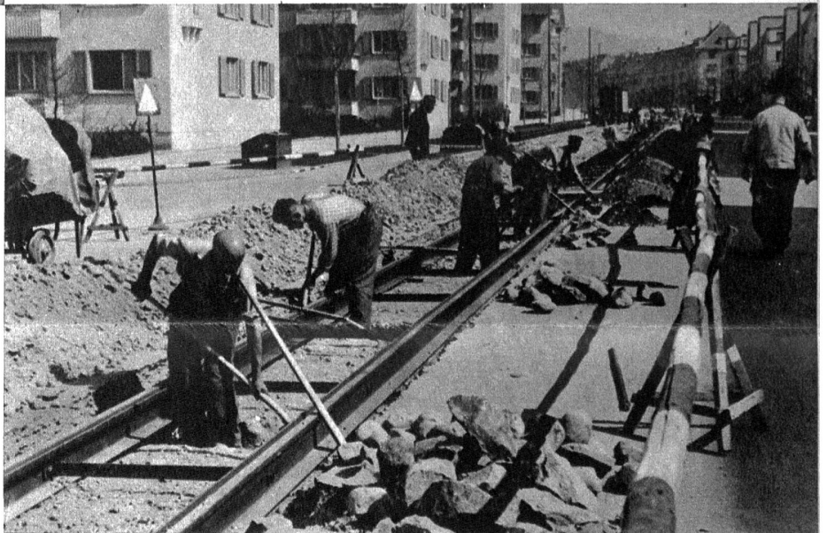
Zwischen den neuangelegten Schienen werden die Löcher für Betonquerswellen gegraben
