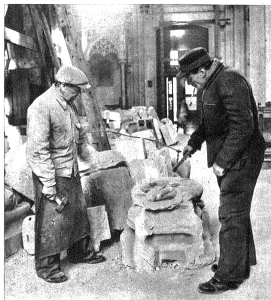
Links: Blick von unten in einen der beiden Glockentürme. Leer stehen sie heute da, ihres Schmuckes, der Glocken beraubt. Auch hier hatten die Feuer gefangen, waren durchgebrannt und mit den Glocken in die Tiefe gestürzt. Mitte: Der Polier Nebel und der Steinmetz Reisinger beraten, wie ein beschädigtes Ornament am besten restauriert werden kann. Rechts: Nur schwindelfreie Arbeiter können hier gebraucht werden. Blick in eines der Schiffe des Domes mit einem Gerüst, welches bis ins Gewölbe hinauf reicht
