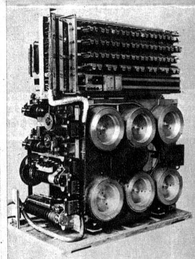
Das Aufnahmegerät des Ipsophons ist hier aus seinem geheimnisvollen Kasten herausgehoben worden. Spulen und Relais machen den so sinnvollen Automaten, dessen Spulenseite unser Bild zeigt, aus
