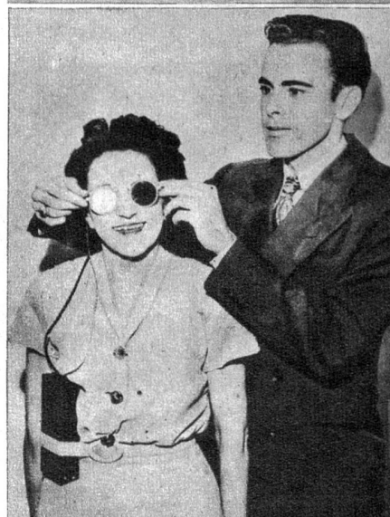
Viertes Bild: Eine ganz hervorragende Erfindung zugunsten der Blinden hat in Ableitung einer amerikanischen Geheimwaffe, der radargesteuerten fliegenden Bombe „BAT“, der junge Kalifornier Byron Brown gemacht. Die Blinde, hier seine eigene Mutter, trägt auf den Augen brillenglasgrosse Metallplättchen, deren eines als „Sender“, das andere als „Empfänger“ dient und aufs Ohr geleitet wird. Durch die Schallrückstrahlung lassen sich so mit dem Ohr alle Körper und auch deren Distanz feststellen, nach einiger Übung sogar genau definieren (ATP)
