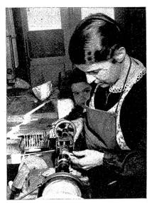
Mechanikteile werden gebohrt
