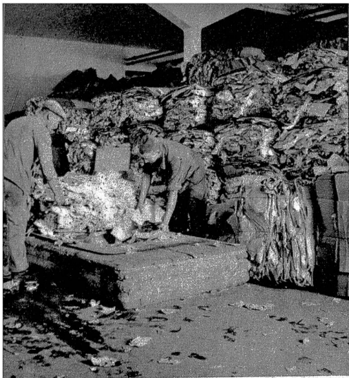
Links: Einfüllen von Altpapier in den Kugelschleifer
