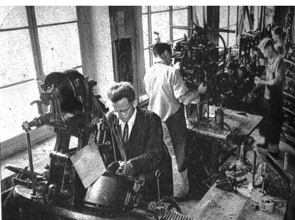
Die Lederschuh-Zwickerei. Hier wird dem Schuh gewissermassen der Charakter gegeben, denn mit Hilfe dieser Maschinen, die Wunder der Technik sind, wird der Schaft über die Form sogenannten Leisten an die Brandsohle befestigt
