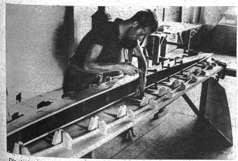
Die stark dem Flugzeugbau verwandte Konstruktion des Schwimmbootes
