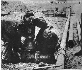
Bild von der Montage der Röhrenleitungen in Frankreid Einsetzen einer Abzweiglinie
