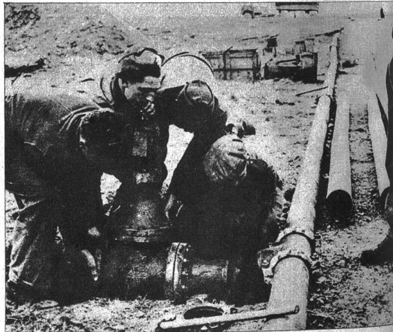
Bild von der Montage der Röhrenleitungen in Frankreich. Einsetzen einer Abzweiglinie
