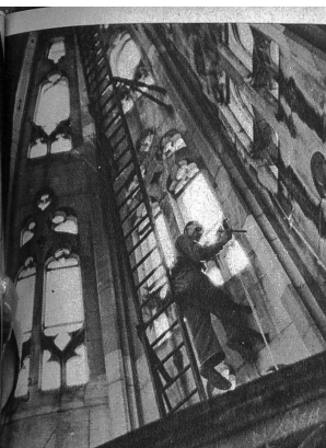
Auch das Innere des Helmes wird bei dieser Gelegenheit nach schadhaften Stellen untersucht
