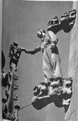
Erst auf den äussersten Zinnen des Turmes lassen sich viele der Sandsteinarbeiten erreichen, die immer wieder untersucht und wenn nötig ersetzt werden
