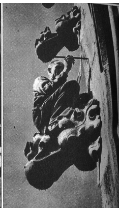
Unterwegs zur Spitze müssen alle gefährdeten Stellen sorgfältig mit dem Meissel abgeklopft werden. Nur das geübte Ohr des Fachmannes erkennt die Schalle
