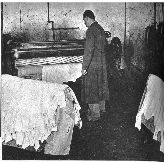
Das weisse Leder (eine Spezialität der Gerberei) wird nach der Gerbung sorgfältig geglättet
