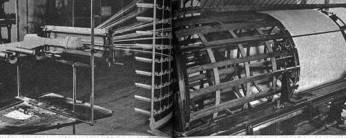
Das Abziehen vom Garn von einer Maschine auf eine ander Bevor das Garn zum Weben gebraucht wird, muss es aufgebäumt werden
