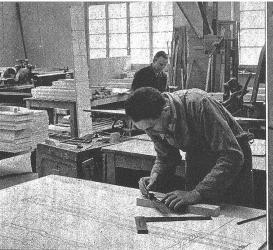
Nach dem Zuschneiden des Holzes wird an Hand der Detailzeichnung angerissen, d. h. dem Schreiner seine Arbeit auf dem Holz vorgezeichnet
