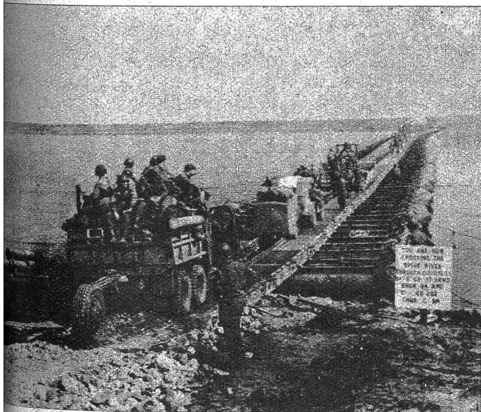
Das amerikanische Genie-Bataillon hat bei der Rhein-Schiffbrücke, die in der Rekordzeit von sechseinhalb Stunden erstellt wurde, sein Können unter Beweis gestellt. Die Schiffsbrücke, welche heute schwerstes Kriegsmaterial zu tragen vermag, musste inmitten der deutschen Feuergegarben errichtet werden
