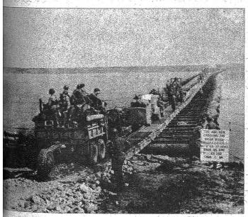
Das amerikanische Genie-Bataillon hat bei der Rhein-Schiffbrücke, der in der Rekordzeit von sechseinhalb Stunden erstellt wurde, sein Können unter Beweis gestellt. Die Schiffsbrücke, welche heute schwerstes Kriegsmaterial zu tragen vermag, musste inmitten der deutschen Feuergarben errichtet werden
