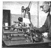
Machine spéciale à rectifier les organes principat de l'étampe après trempe Eine Spezialmaschine zur Rektifikation einzelne Teile der Stanzen nach der Härtung
