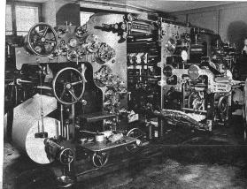
Buchdruckrotationsmaschine für den Zeitungsdruck
