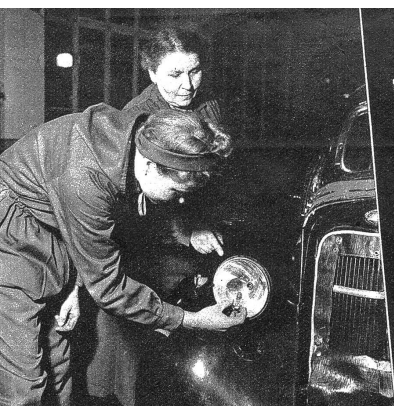
Die Birne des Scheinwerfers wird gewechselt. Hier heisst es aufpassen, dass das Löffel richtig oben ist
