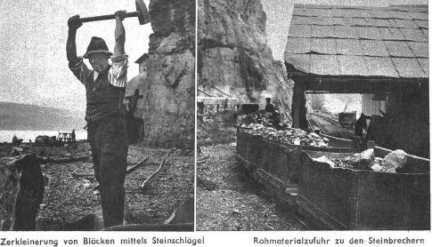
Rohmaterialzufuhr zu den Steinbrechern
