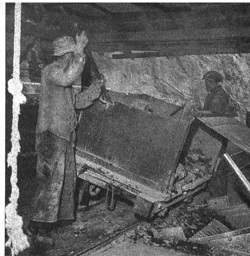
Kippen der Kastenwagen in das Brechermaul Unten: Lastschiff unter dem Transportband. Im Vordergrund Hausteine
