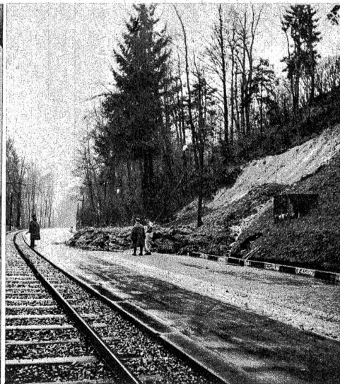
Infolge der zahlreichen Regenfälle kam an der Tiefenastrasse, unterhalb der Äussern Enge, der Hang ins Rutschen und versperrte die Tiefenastrasse in ihrer ganzen Breite
