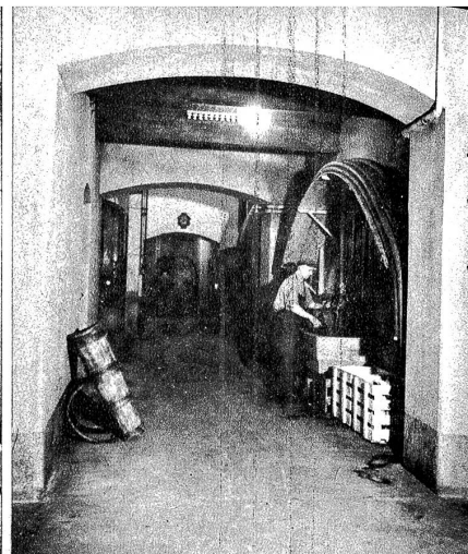
Durchgang in den grossen Zisternenkeller
