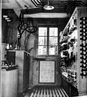
Elektrizitätsversorgung. Blick in eine der zahlreichen Transformatorenstationen, wo die elektrische Energie von Hochspannung auf Gebrauchsspannung umgewandelt wird
