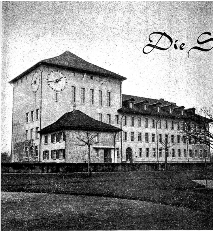
Das neue Primarschulhaus
