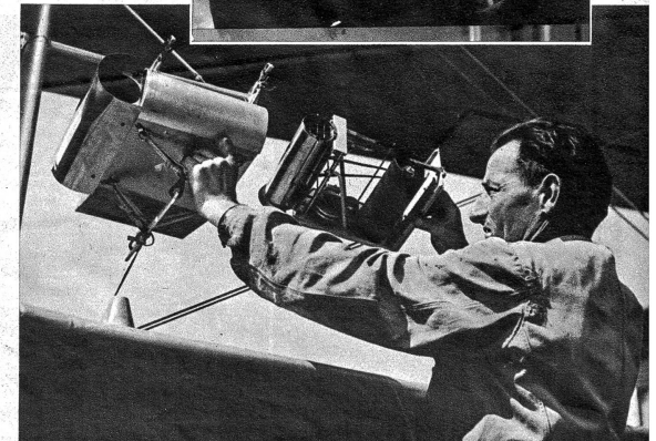
Unterdessen wird der Meteorograph, welcher die Flughöhe, die Lufttemperatur und die Feuchtigkeit registriert, in Gang gesetzt
