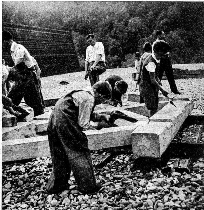
Damit das Gewerf „alt“ aussieht, beeten sich die jungen Laupener Blider schützen, die scharfen Kanten mit Aexten zu brechen
