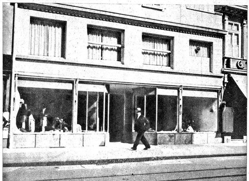
Frontansicht des Geschäftshauses der Firma Löffler & Cie.
