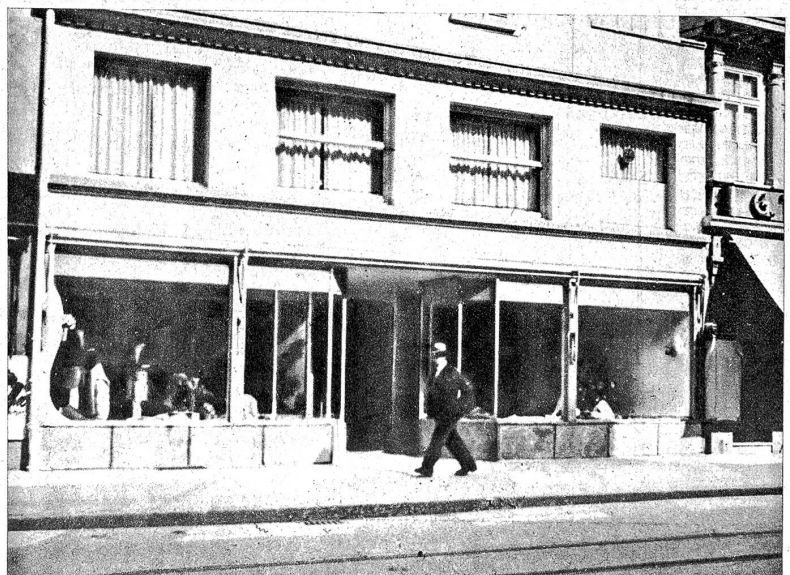
Frontansicht des Geschäftshauses der Firma Löffler & Cie.
