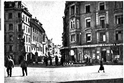
Alle Mühlebrücke. Heute sind nicht mehr viel Spuren der alten Mühlebrücke vorhanden
