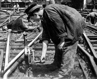
10 Tonnen Traglast überwindet die Stahlgeleisewinde, die zur Nivellierung der Schienen benützt wird. Nur ausgesuchtes Material und sehr gewissenhafte Ausführung garantieren für die Leistung
