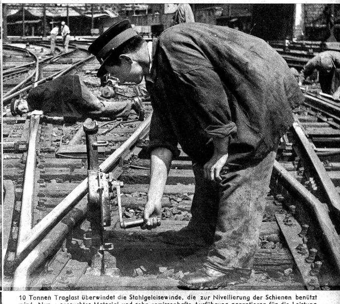
10 Tonnen Traglast überwindet die Stahlgeleiswinde, die zur Nivellierung der Schienen benutzt wird. Nur ausgesuchtes Material und sehr gewissenhafte Ausführung garantieren für die Leistung
