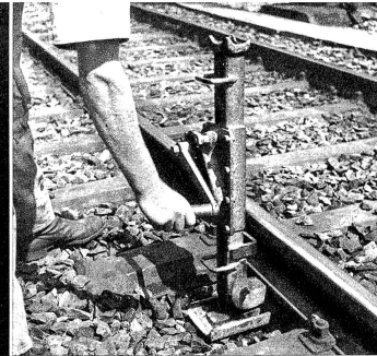
Die Stahlgeleiswinde wird angesetzt
