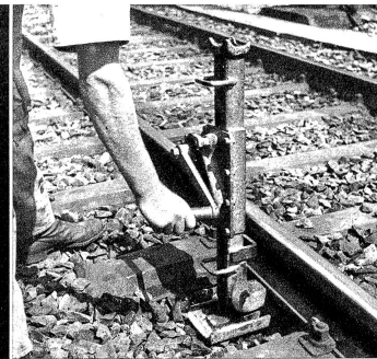
Die Stahlgeleiswinde wird angesetzt
