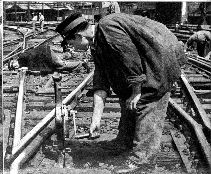
10 Tonnen Traglast überwindet die Stahlgeleiswinde, die zur Nivellierung der Schienen benützt wird. Nur ausgesuchtes Material und sehr gewissenhafte Ausführung garantieren für die Leistung
