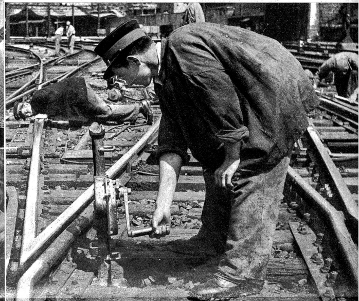
10 Tonnen Traglast überwindet die Stahleiswinde, die zur Nivellierung der Schienen benützt wird. Nur ausgesuchtes Material und sehr gewissenhafte Ausführung garantieren für die Leistung
