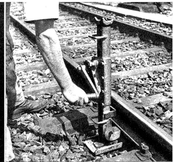
Die Stahlgelisewinde wird angesetzt
