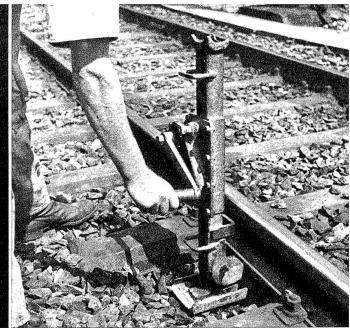
Die Stahleiswinde wird angesetzt
