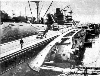
Im Hafen von Neapel haben amerikanische Pioniere auf einem umgekippten Transportdampfer ein Landebrücke gebaut. Auf diese Weise häre von der die Schladseit Landebrücke gebaut. Auf diese Weise können die Nachschubschiffe neben dem mit Schlagsell auf Grund liegenden Schiff gelöscht und der Hafen seinem Zwecke nutzbar gemacht werde
