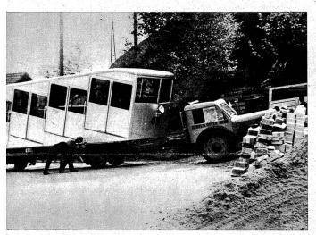
Der Umbau der Gurtenbahn ist in voilem Gange! Die Geleisearbeiten sind weit fortgeschritten und der erste neue Gurtenbahn-Wagenkasten fährt zur Talstation, wo an Ort und Stelle, auf dem Geleise, die Montage auf das neue Wagenuntergestell vorgenommen wird
