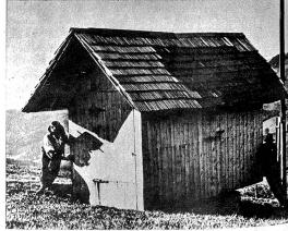
Auf halber Höhe des Schindelbergs steht das von den Genossenschaftern gemeinsam erbaute Maschinenhaus mit Motor und Seilwinde. Ein einfacher, von den Bauern selbst angeregter Mechanismus erlaubt die beliebige Drehung des Hauses und ermöglicht die Verwendung der Seilwinde in jeder Richtung
