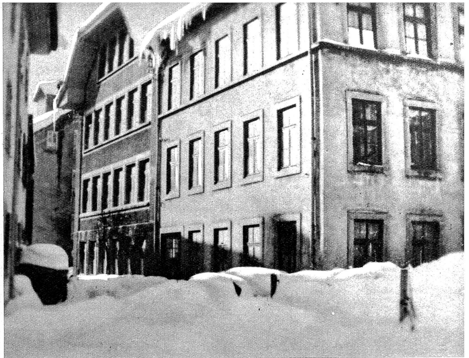
Ansicht eines Teiles der Fabrik Adrien Lador SA. Ste-Croix
