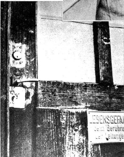
Links: Die verhängnisvolle, elektrisch geladene Türe, welche einem Arbeiter das Leben kostete und damit Anstoß gab zu einer polizeilichen Untersuchung. Die Türfalle wurde mit einer Spannung von 1600 V geladen
