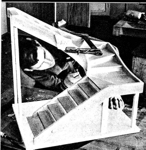
Der ZIMMERMANN arbeitet viel nach Modellen. Hier ein junger Arbeiter beim Bau eines komplizierten Treppenmodells
