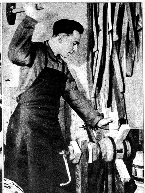
DER WAGNER. Das Bestücken mit den zugeschnittenen Speichen
