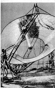
Der Sonnemotor von Passadena bei Los Angeles. Die Sonnenstrahlen werden auf einem Dampfkessel konzentriert. Das Pumpwerk, welches dieser Motortreibt, schöpft 5000 Liter Wasser in der Minute
