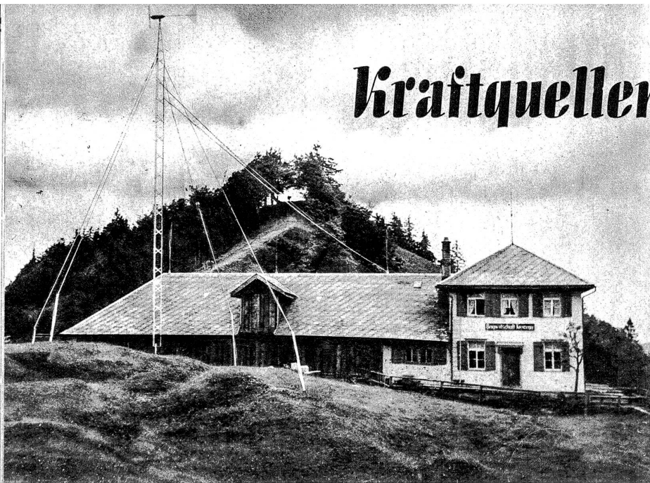
Ein Windlader in der Schweiz. Das Bergwirthshaus auf der Kreuzegg (Kt. Thg.) bedient sich schon seit 2 Jahren der Windkraft als Quelle billigen Verbrauchstromes
