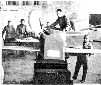
Ausbildung im „Linktrainer“. Hier erlernt der Pilotenschüler das Fliegen nach den Bordinstrumenten, den sogenannten Blindflug. Obschon er in zugedeckter Kabine „fliegt“, kann er vom Fluglehrer genau kontrolliert werden. Am Kommando wird auf einem Blatt der „Flugweg“ automatisch aufgetragen. Befehle und Weisungen werden dem Schüler in Telefonie oder Telegrafie übermittelt
