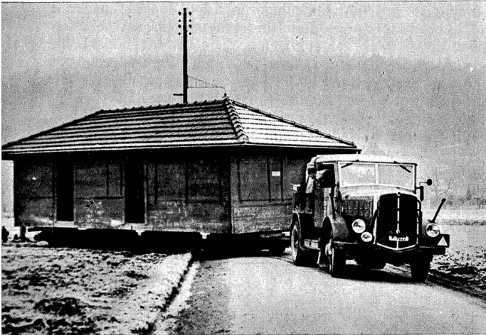
Wenn der Baumeister die Schölle betrifft, so muss der Pflanzler weichen. Aus diesem Grunde wurde letzte Woche das 10 m lange Pflanzlerhaus der Firma Dr. Wander AG. vom Liebefeld nach dem neuen Areal im Steinhölzli transportiert
