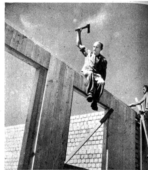
Die Wände werden auf dem Bauplatz montiert
