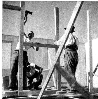
Auf dem Bauplatz werden die Bauelemente aus Holz aufgerichtet
