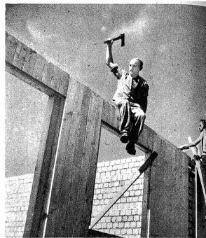
Die Wände werden auf dem Bauplatz montiert
