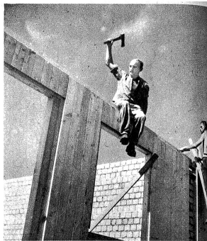
Die Wände werden auf dem Bauplatz montiert
