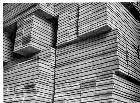
Oben: Fertige Wandtafeln für den Siedlungsbau warten auf den Abtransport zum Bauplatz. — Links: Durch sorgfältige Vorbereitung konnten die einzelnen Häuser in kurzer Frist fertiggestellt werden
