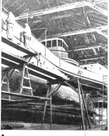
eines reibungslosen Stapelganges ein wichtiger Moment. Sitzt das Schiff einmal richtig auf dem Wagen, so wird die Aufzugswinde in Betrieb gesetzt, die mittelst starker Stahltrossen den schweren Wagen
