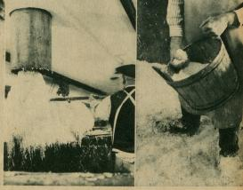
Links: In dieser Maschine wird das Kraut fein gehobelt und durch einen Trichter in der unteren Stock abgeleitet - Rechts: Das ist ein wichtiger Mann bei der Sauerkrauffabrikation. Er verteilt das Salz und ist verantwortlich, dass nicht zuviel, aber auch nicht zuwenis gesalzen wird. Mit sauberen neuen Holzschuhen wird dann das Kraut gestampft
