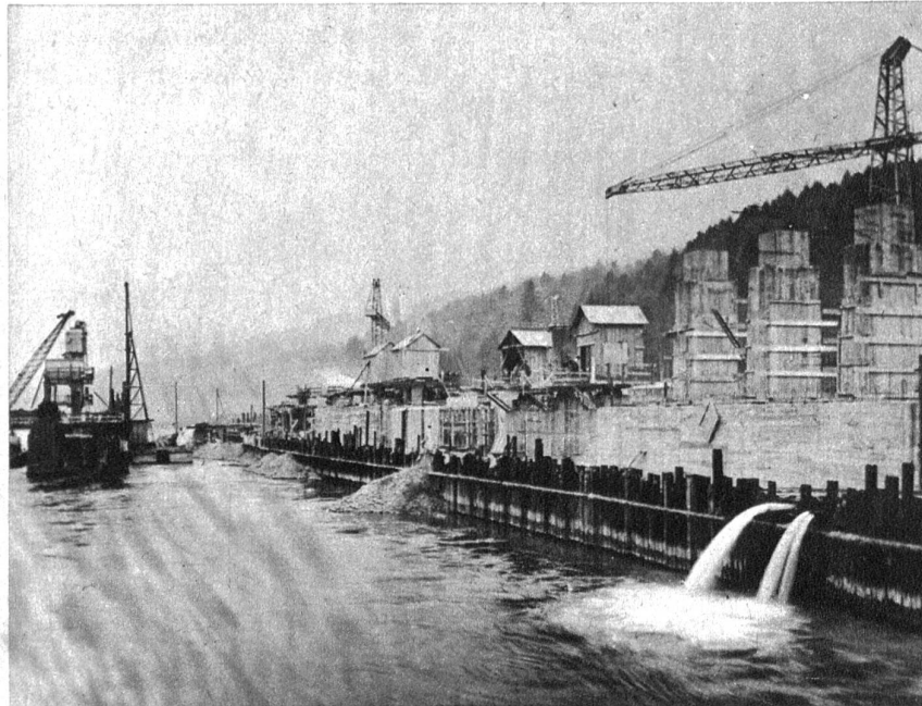
Das Kraftwerk Ruppertswil-Auenstein im Bau. Die Trennmauer zwischen Aare und Maschinenhaus im Bau. Links in der Aare ein in Bau befindlicher Stauwehrpfeiler. Mit dem von der Schweiz. Bundesbahnen und den Nordostschweizerischen Kraftwerken erstellten Werk werden die Aarewasserkräfte zwischen Aarau und Wildeggen ausgenützt (Nr. 6216 BRB 3. 10. 39)
