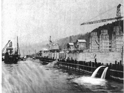
Das Kraftwerk Rupperswil-Auenstein im Bau. Die Trennmauer zwischen Aare und Maschinenhaus im Bau. Links in der Aare ein in Bau befindlicher Stauwehrpfeiler. Mit dem von den Schweiz. Bundesbahnen und den Nordostschweizerischen Kraftwerken erstellten Werk werden die Aarewasserkräfte zwischen Aarau und Wildegg ausgenützt (Nr. 6216 BRB 3. 10. 39)
