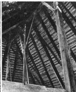
Links: «Althaus»-Einzelheiten. Der ganze mächtige Bau ruht auf gewaltigen, verzäpfen Eichenschwellen. Laubenlader und Fenstergesimse sind reich geschnitzt — Rechts: Heubühne des Althauses. Konstruktion eines Hochstuhlhäuses. Eines der letzten auf Berner Boden.
