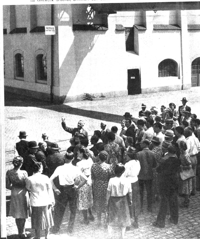
Technischer Adjunkt der Direktion, J. Wyserer, der seit dem Jahre 1921 im Gaswerk arbeitet, erläutert den Besuchern die Anlagen des Betriebes
