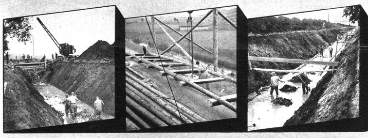
Aushub mit Bagger, im Vordergrund Aushub von Hand für die Querschwellen des Holzeinbaues
