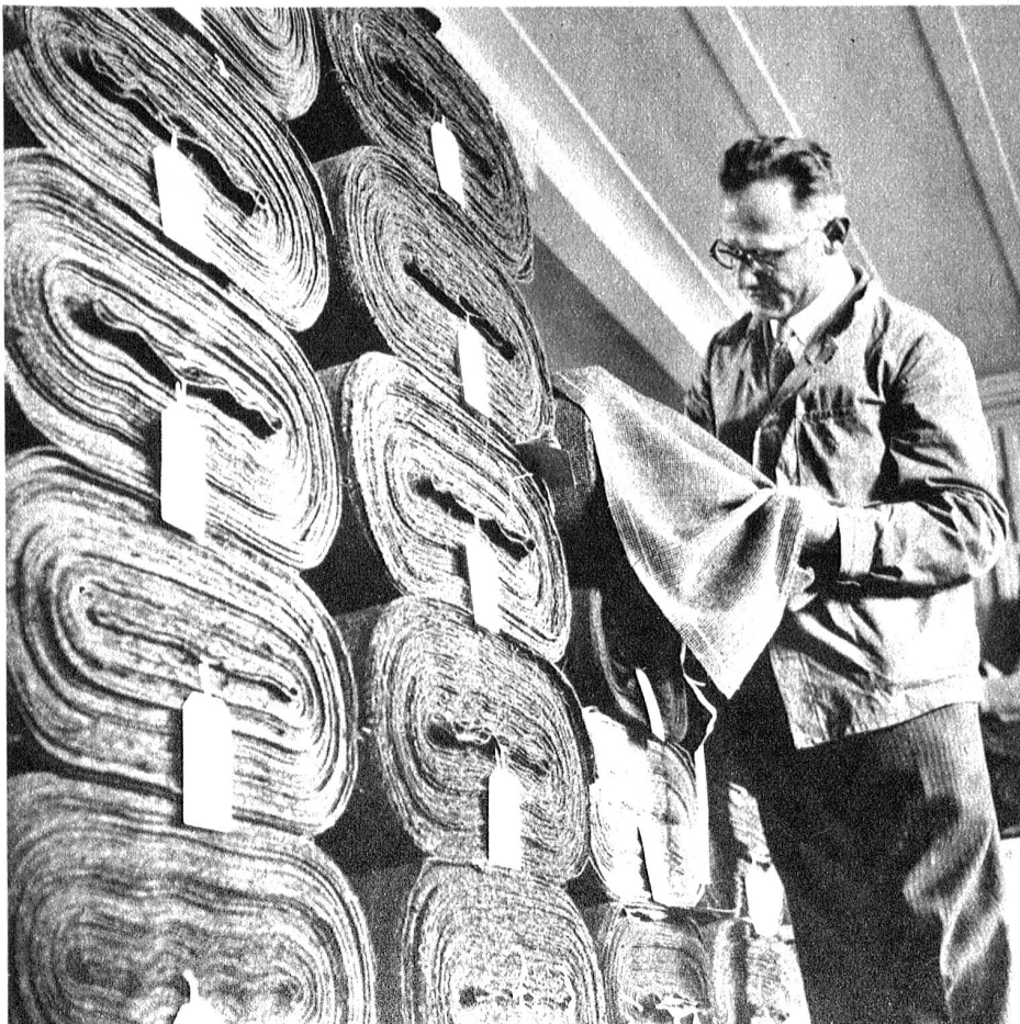
Das Ausnähen und die Kontrolle der rohen Stücke Links: Die Nachkontrolle der fertigen Stoffe Unten: Die rohen Stoffe werden gewalkt
