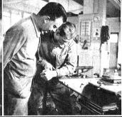
Schaben der Gleitbahnen: eine Präzisionsarbeit mit höchstem Einfluss auf die Arbeitsgenauigkeit der Maschine
