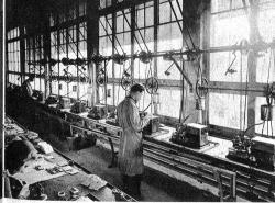
Rechts: Das Drehen der Steine wird auf 1.5 tausendstel Millimeter genau ausgeführt Links: Herr F. W. Räz bespricht mit seinem Sohn Hans die Arbeitsfolge des Tages
