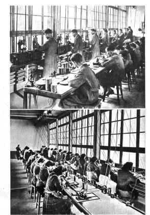
Die Steine werden vorgedreht und geformt. Oberes Bild: Auf zwei- bis vierhundertstel Millimeter (0.22 - 0,27 mm) genau werden die Planflächen der Steine von ihrer ursprünglichen Dicke abpoliert. Unten: Die geformten Steine werden mit einer Oelsankung versehen
