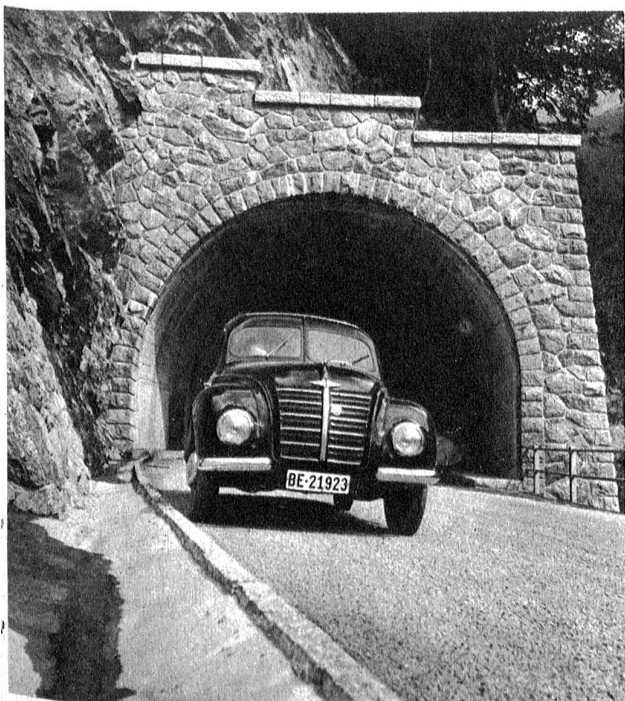
Zukunftsmusik und Wirklichkeit. Ein Auto hat soeben eine Lawingalerie passiert, deren Eingänge in Natursteinverkleidungen sich ausgezeichnet dem Landschaftsbild einfügen Bilder links: 3 Hornstösse bieten Einhalt! — Aus einem Stollen eine sich eiligst in Sicherheit bringende Gruppe von Mineuren, — drei sich in kurzen Abständen folgende ohrenbetäubende Explosionen, ein vielfaches Echo an den nahen Flöhen, eine berstende Felswand, stiebende Steinblöcke und eine grosse, graugelbe, uns jegliche Sicht nehmende Staubwolke, sind die Angelegenheit von Sekunden. Wo der Bohrer nicht mehr durchkommt, tut das Dynamit, von kundiger Hand gelenkt, seine Pflicht
